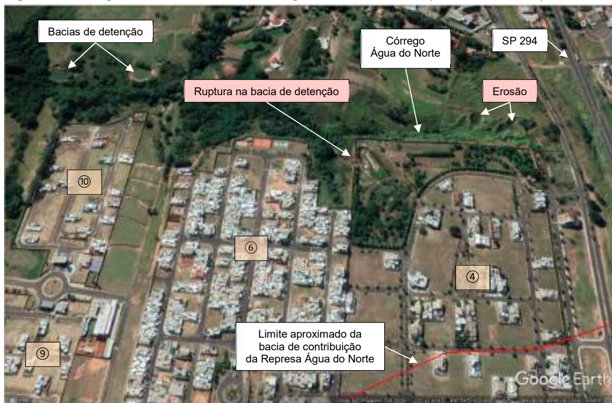
Figura 27. Vista geral da área de interesse, imagem de 09-maio-2020 (Fonte: GEP, 2021).
