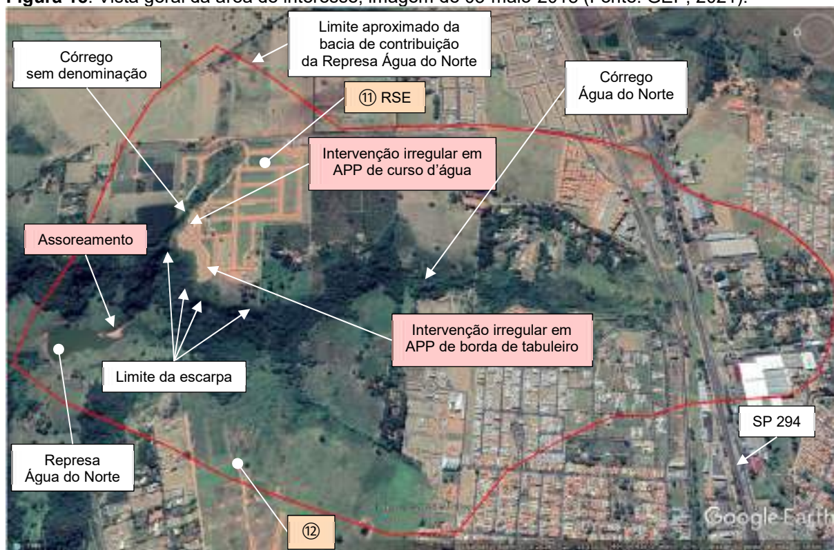
Figura 18. Vista geral da área de interesse, imagem de 03-maio-2018 (Fonte: GEP, 2021).
