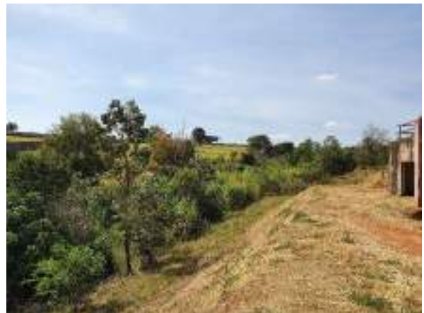
Foto 8. APP de corpo d'água – margem esquerda: Ausência de vegetação na região do talude do salão de festas.
